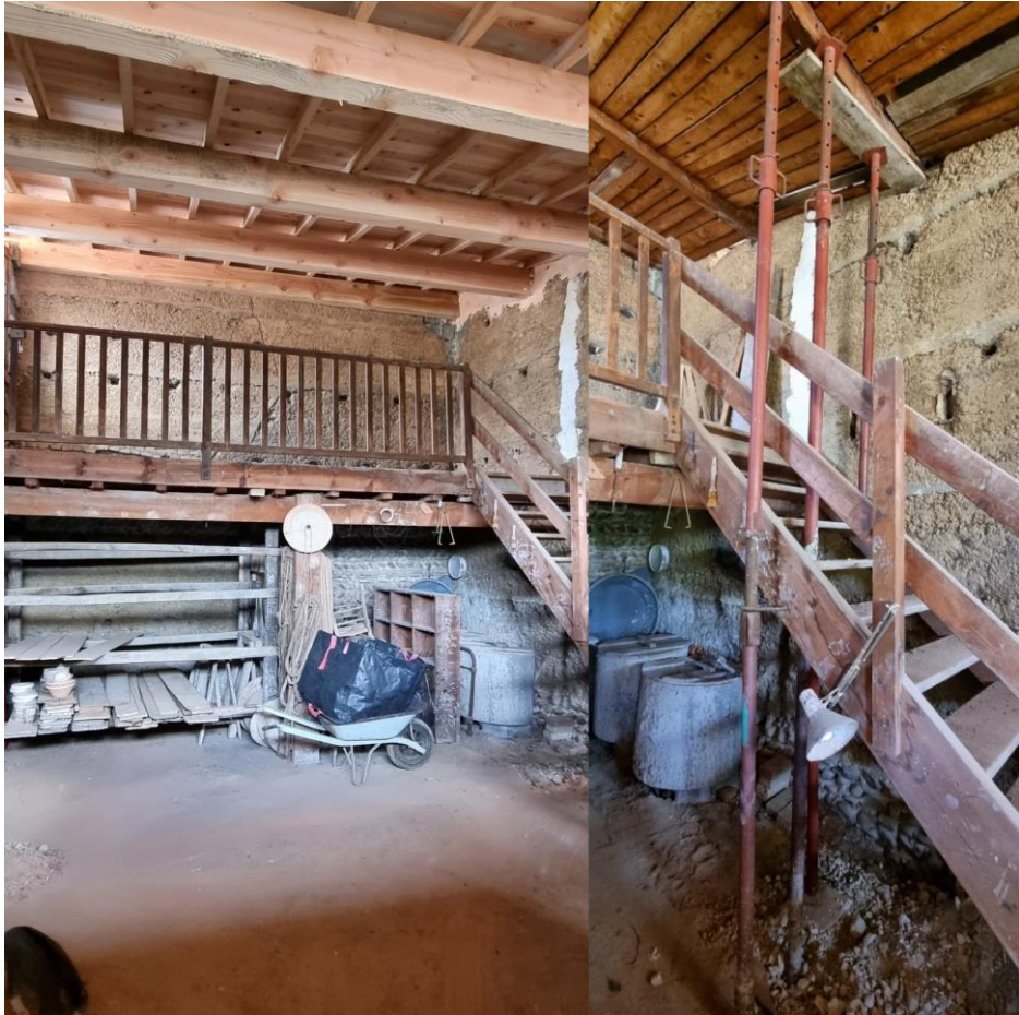
Reprise de la charpente des ateliers
