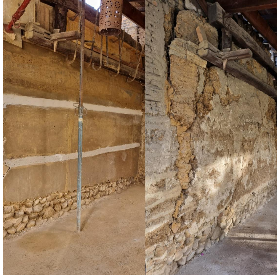
Rénovation du mur ouest du four en terre coulée
